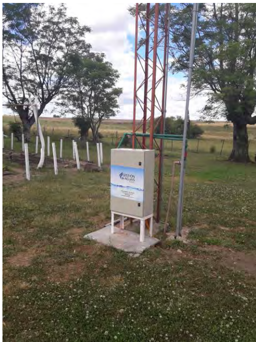
Caseta del filtro de carbón activado
