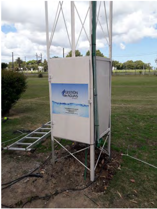
Sistema de osmosis inversa previo a los puntos de agua potable (cocina y canilla)
