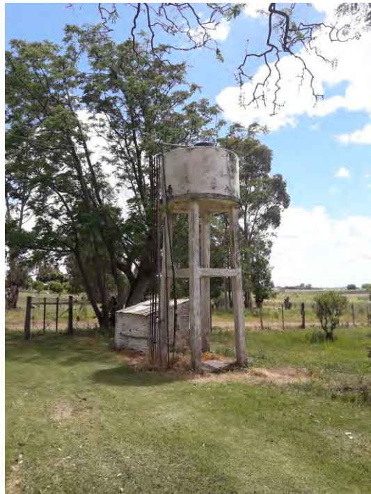
Nuevo tanque instalado dentro del tanque original
