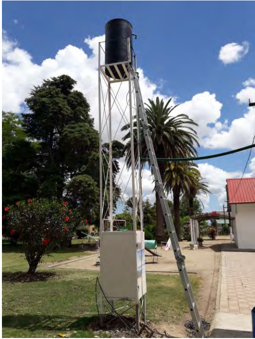
Sistema de osmosis inversa previo a los puntos de agua potable (cocina y canilla)
