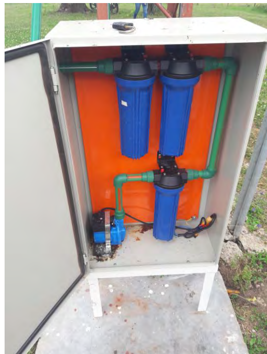
Caseta del filtro de carbón activado
